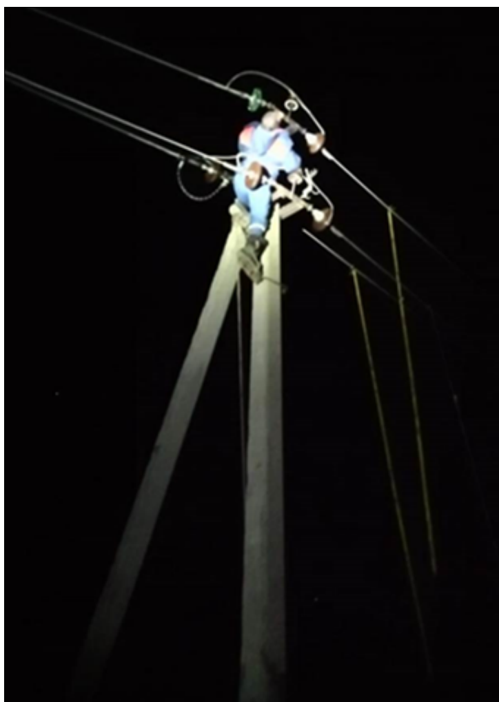
Опора № 37 ВЛ 10 кВ 1004 от ПС Черкутино
